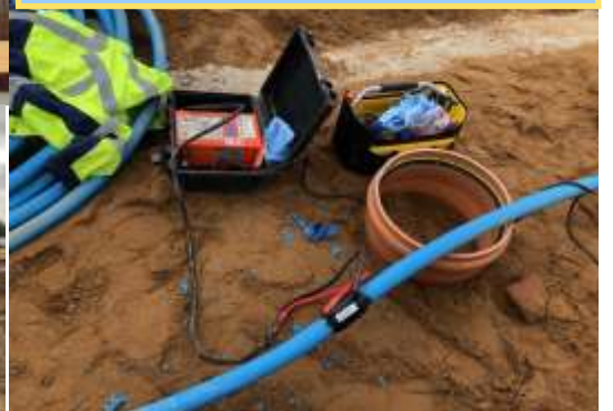
Egtved Vandværk var også på sitet i dag for at forberede den kommende vandtilslutning. 2 længder PEL-rør samles med en elektromuffe.
