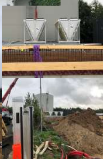
Egtved Vandværk var også på sitet i dag for at forberede den kommende vandtilslutning. 2 længder PEL-rør samles med en elektromuffe.
